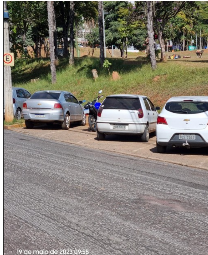
Figura 4.1 – Decapagem do asfalto – Av. Rio Doce
